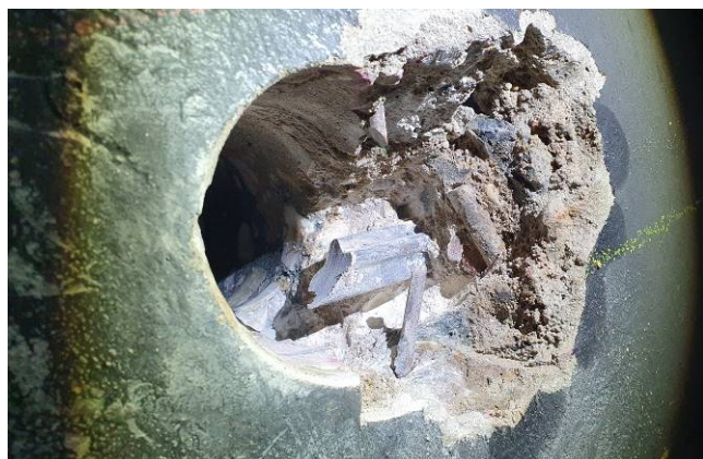
Obr. č. 3 - detail výztuže v sondě SNK1
