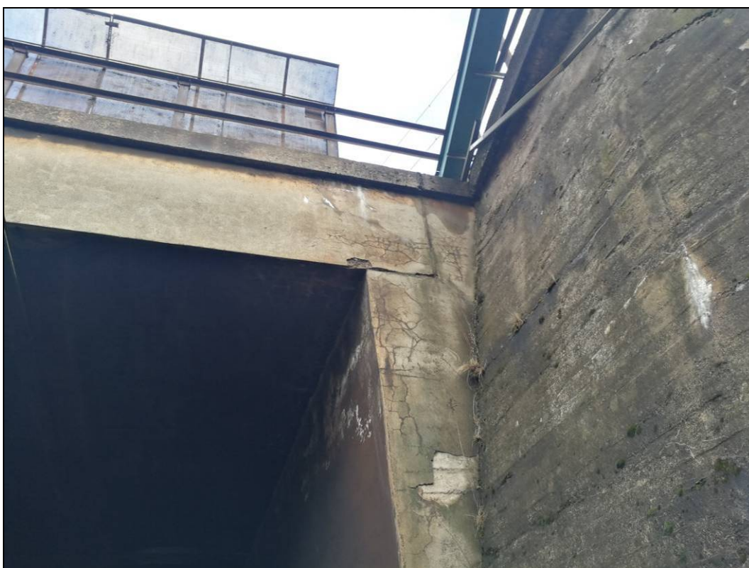
Obr. č. 8 - pohled na vlasové trhliny v čele
