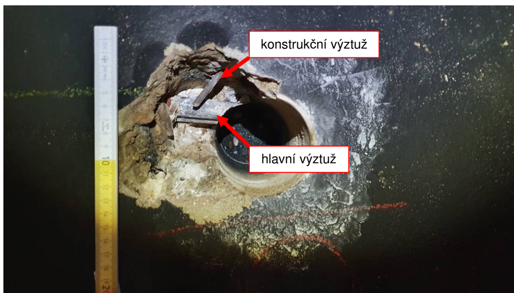
Obr. č. 2 - pohled do bourané sondy SNK1
