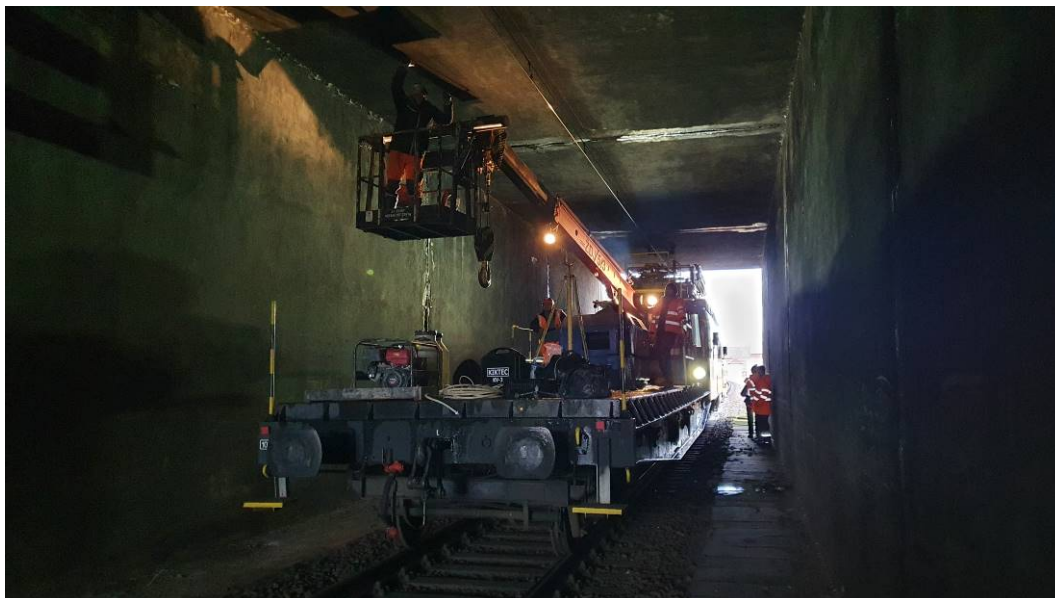
Obr. č. 1 - provádění průzkumu na spodním líci nosné konstrukce
