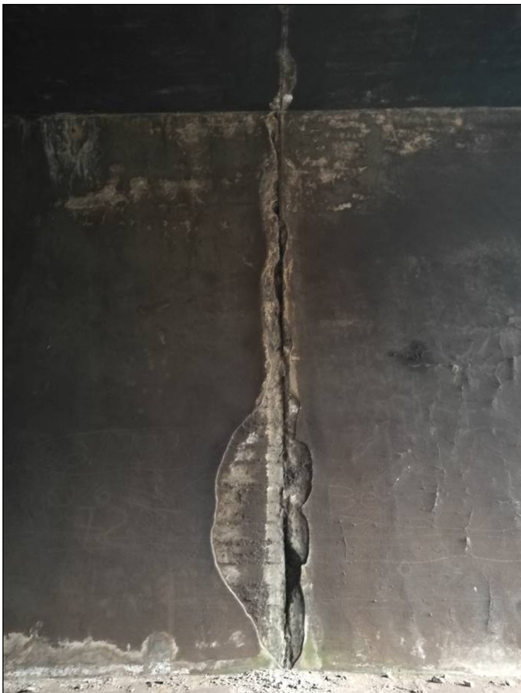
Obr. č. 6 - pohled na DS - opady omítky a betonu v jejím okolí
