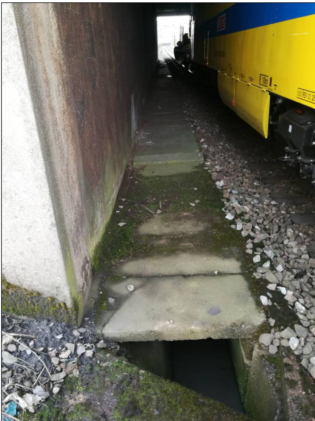
Obr. č. 9 - pohled na příkopové zídky s betonovými poklopy
